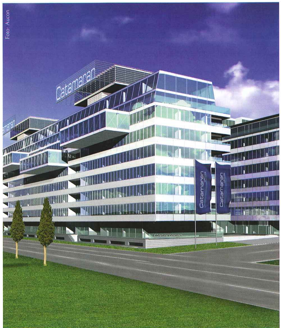
Mit dem Catamaran entsteht derzeit am Donauufer eines der modernsten Bürogebäude der Stadt.
